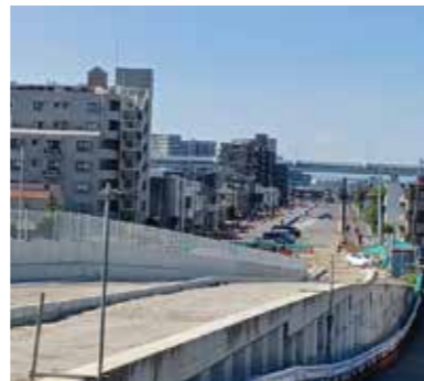
道場三室線整備の現状 10月18日撮影
