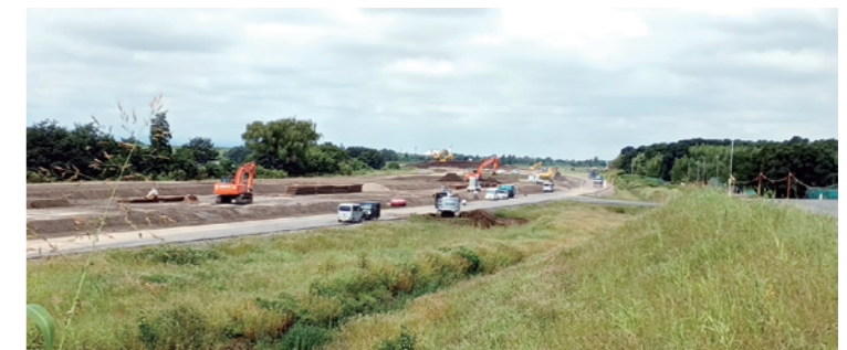
荒川第二・三調節池工事
