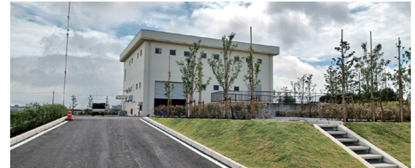
油面川排水機場
